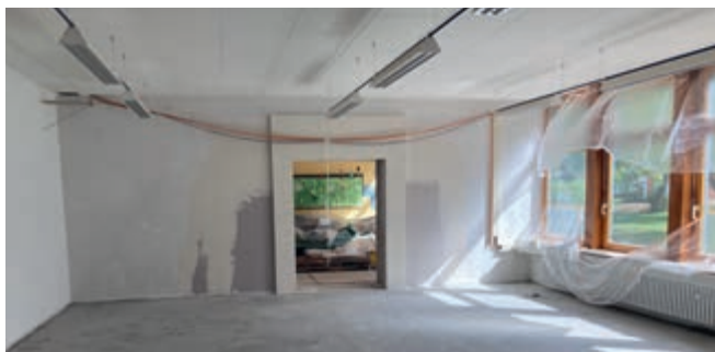
Foto 1 – Raum während der Umbauarbeiten: Der neue Wanddurchbruch ist bereits zu erkennen.
