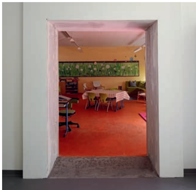
Foto 6 – Neuer Wanddurchbruch: Der neue Durchgang verbindet die beiden Betreuungsbereiche miteinander.
